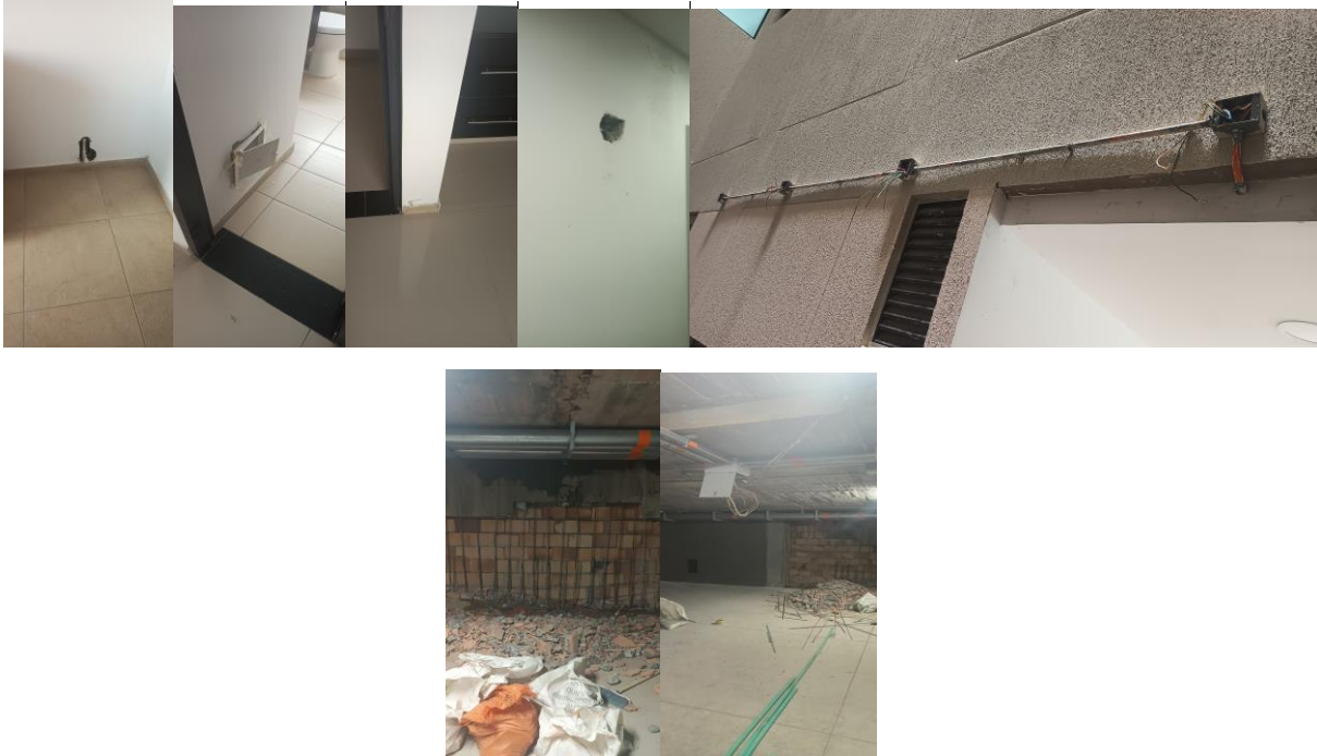
Fuente: Archivo fotográfico de visita a la Obra 30-04-2024
